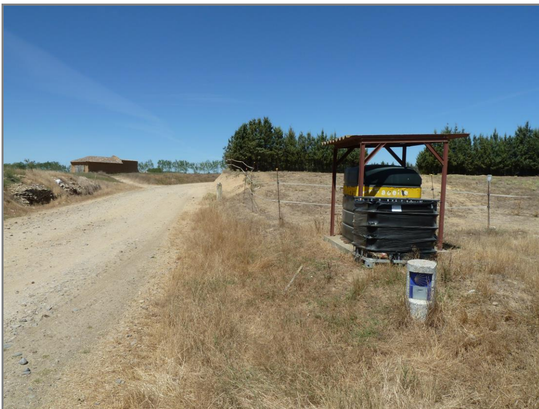
Fotografía A-16. Espacio para residuos de aceite de motor y envases junto al Camino de Santiago.
