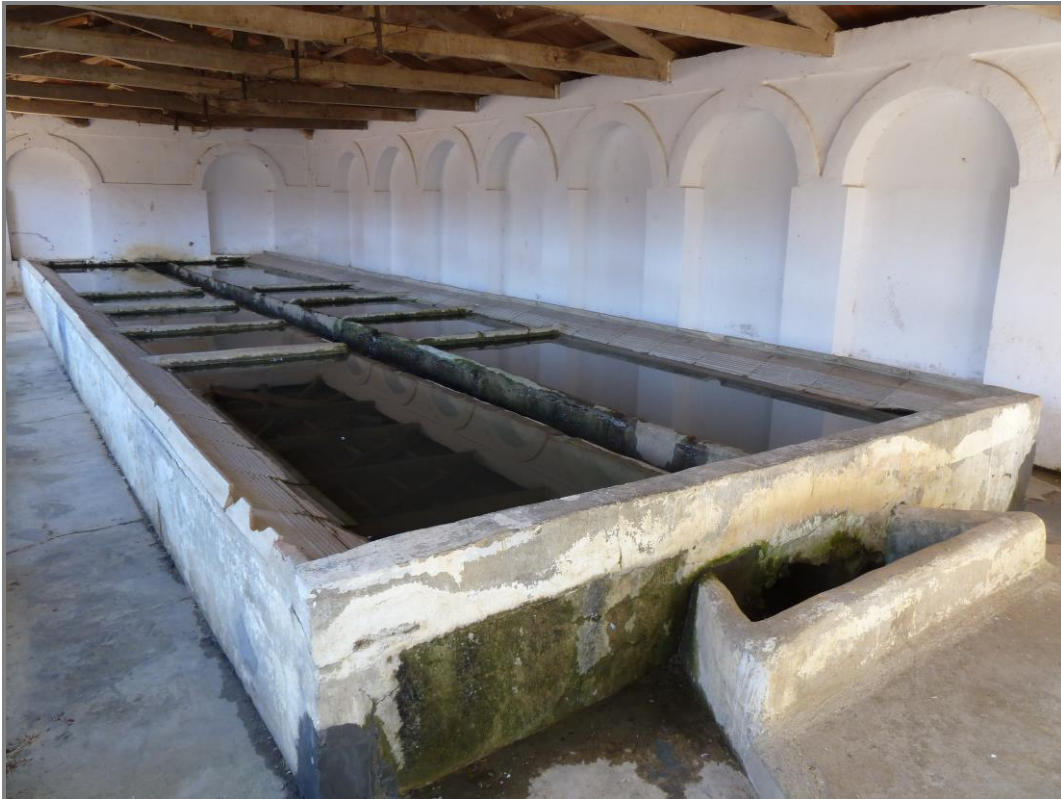
Fotografía A-5. Aspecto de antiguos lavaderos.
